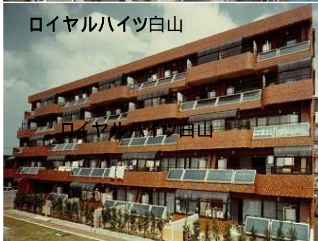
太陽電池・太陽熱併設システム 集熱器4枚+太陽電池24枚(3.60kW)
