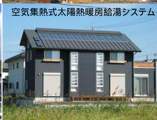
太陽電池・太陽熱併設システム 集熱器4枚+太陽電池24枚(3.60kW)
